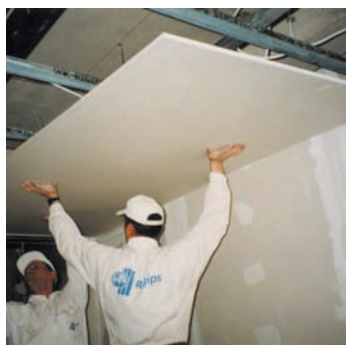
Oblaganje se vrši Rigips pločama debljine 12,5 mm (9,5 mm) koje se šrafe vijcima od 35 mm.
