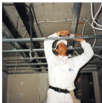
Drugi red CD-profila vezuje se za prvi red pomoću krstastih spojnika i tako se formira "roštilj" konstrukcija.
